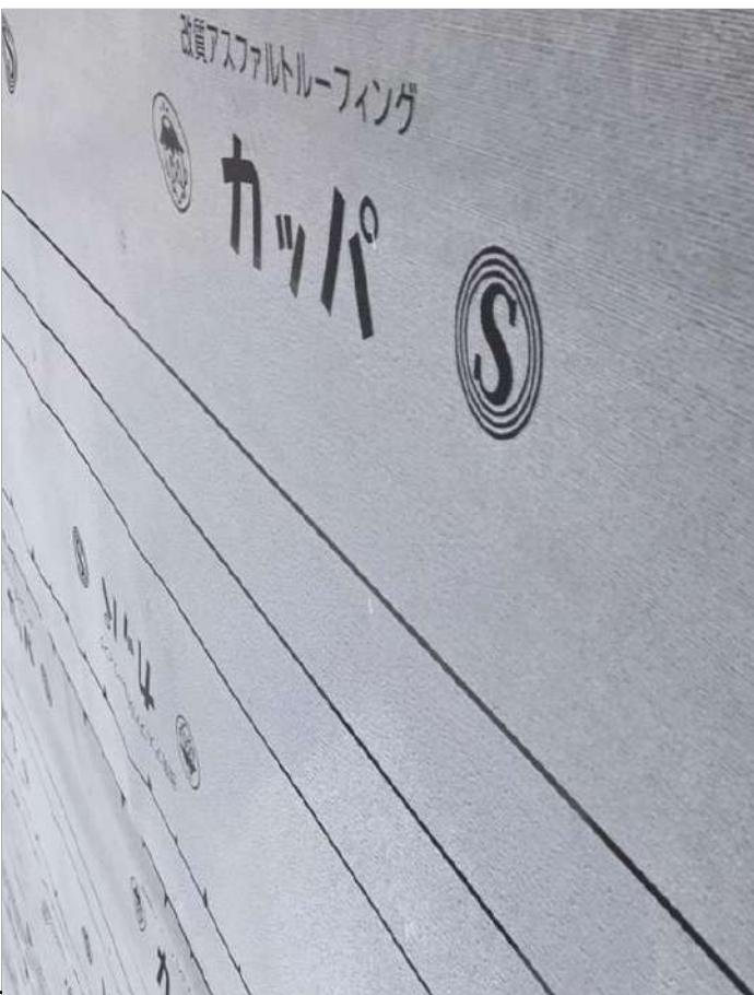
1-23 屋根ルーフィングの立ち上がり250mm以上確保し、上端は気密テープで圧着する。かつ雨押さえ上端より50mm以上とする
