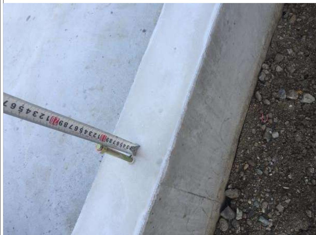
1-3□基礎天端の高さを水準器を使用し、水平確認する。天端レベルに合わせて調整パッキンを使用する。
