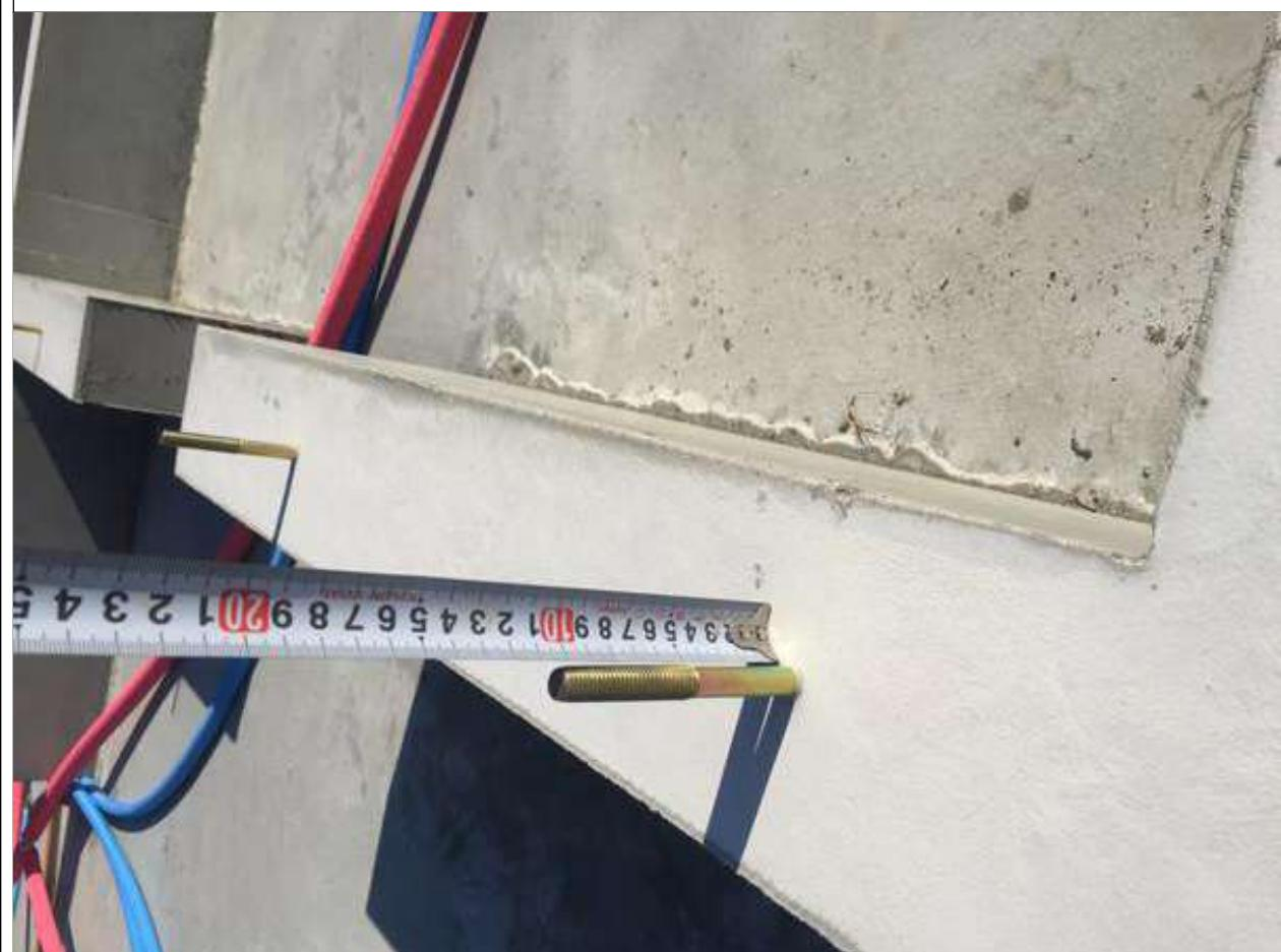
1-2口アンカーボルトのコンクリート埋込み長さは250mm以上とし、アンカーボルトの先端は土台の上端よりナットの外にねじが3山以上出るように固定する。
