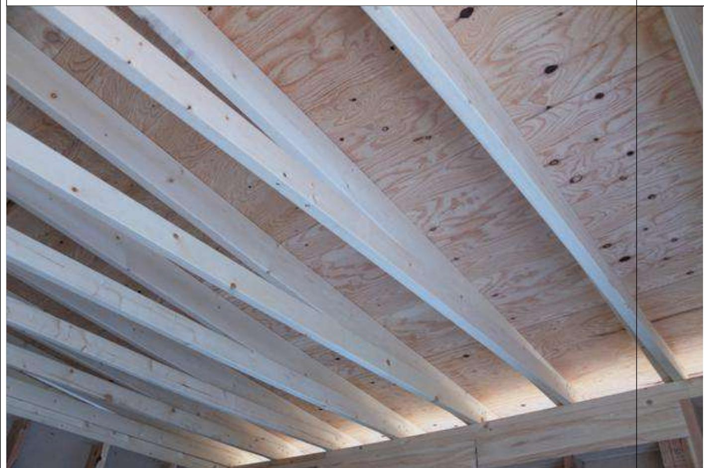
1-19 内側から見て屋根に外し釘がないか確認する。釘は合板端部より10~15mm離す。(2/4)
